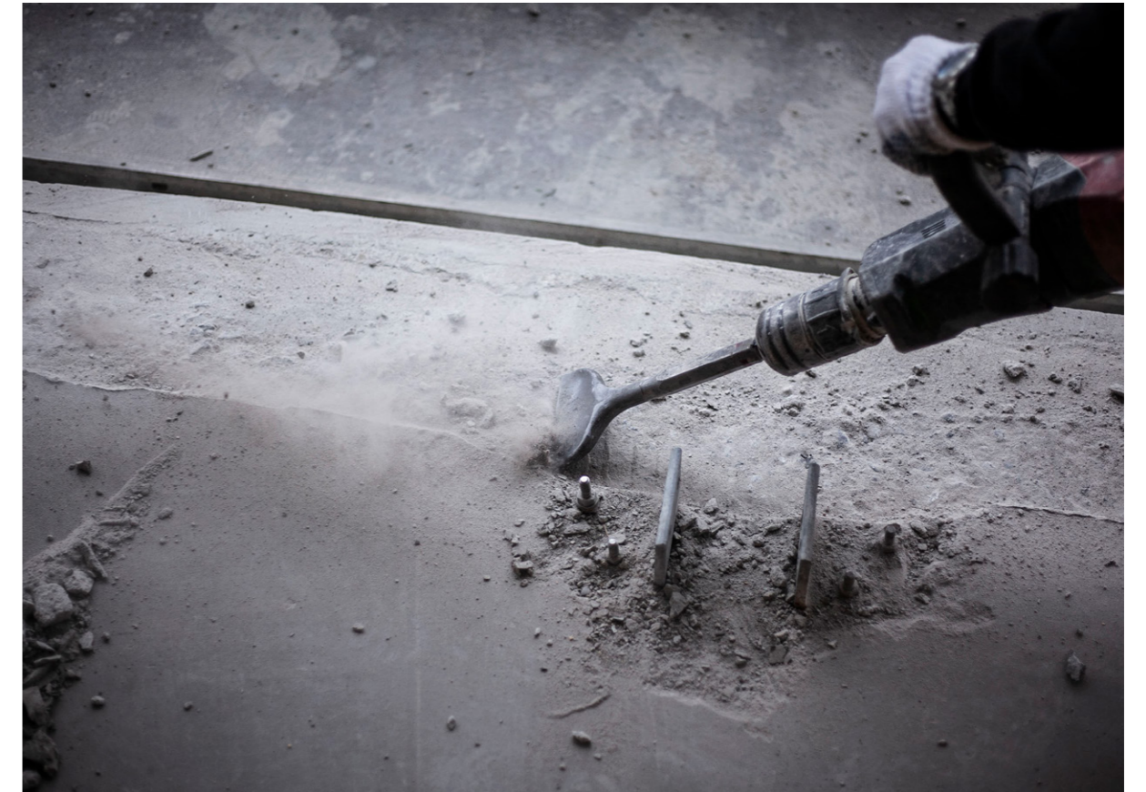
Betondæk ophugges som en del af en nedrivning.
