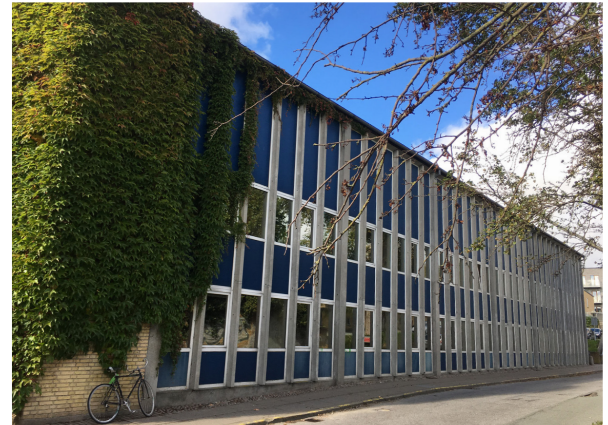
Den tidligere Kommunale administrationsbygning på Knudrisgade.
