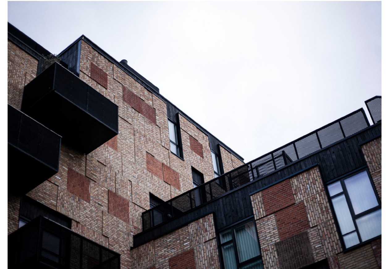
Ressourcerækkerne's facade er opbygget som en mosaik af udskåret genbrugstegl
